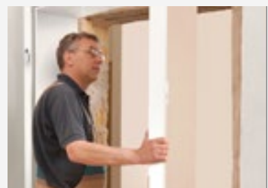
Ab Werk montierte Zargen erleichtern den Einbau vor Ort
